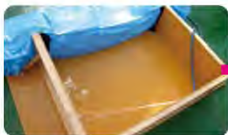
仮設プールで止水テスト開始
